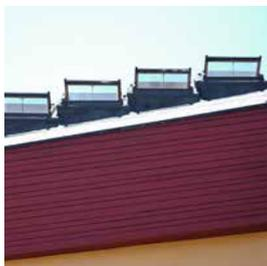
Durch die Instandsetzung des Dachstuhles wird auch im 3. Obergeschoss an heißen Sommertagen wieder normaler Unterricht möglich sein. Über 20 Dachfenster werden durch große Gauben ersetzt.
